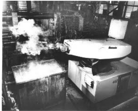
FIGURE 1.1 : Le premier robot industriel Unimates installé dans l'usine de General Motors en 1961, permet d'effectuer le déchargement d'une machine de moulage sous pression de pièces en acier.
